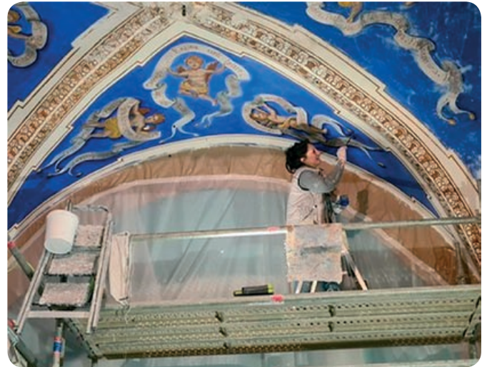
Anne Bonneau à la restauration de la voûte de l'église de Floressas.
